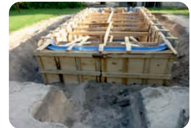
После завершения бетонирования боковых стенок опалубка снимается, пространство между бетонной стенкой и котлованом засыпается песком с одновременной проливкой его водой и уплотнением.
